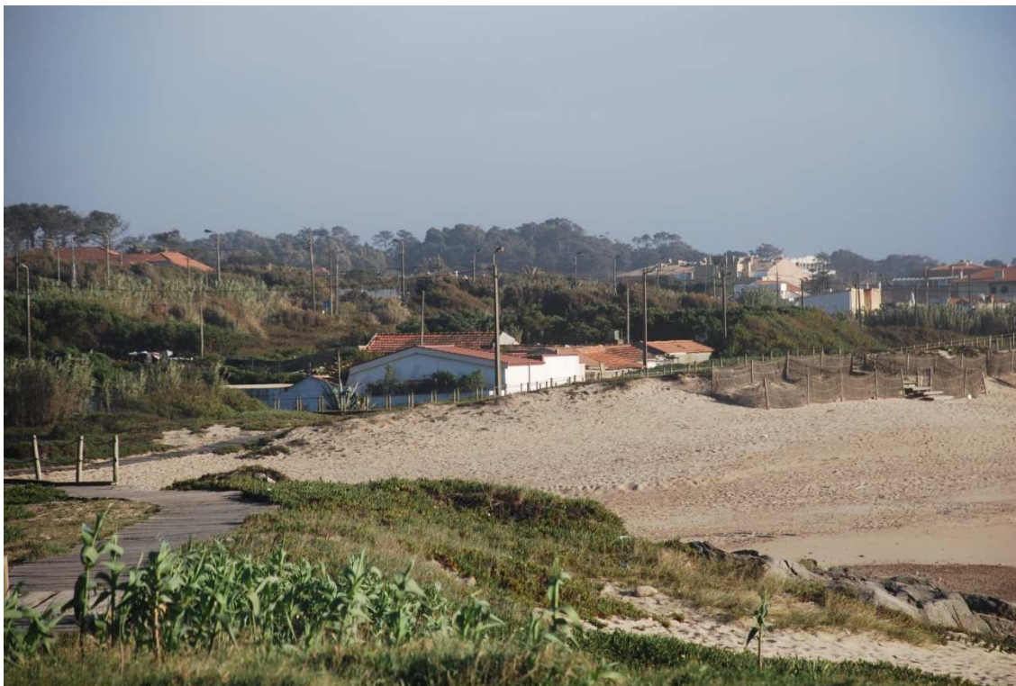
Figura 3: Pormenor do litoral da Madalena. Encontra-se prevista a demolição das habitações clandestinas aqui existente.
