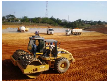
Figura 3 – Preparação camada solo de fundação ( https://www.geosensori.com.br/2019/05/30/a-preparacao-do-solo-numa-obra/ )
