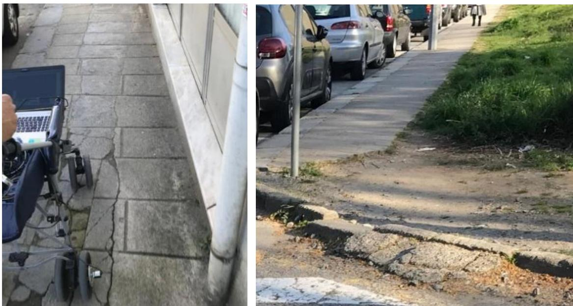
Figura 34 – Desagregação dos materiais de pavimentação na rua do Taxa, em Braga
