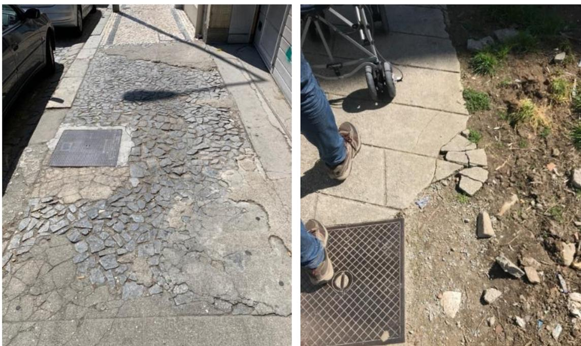
Figura 33 – Desagregação de materiais na rua Conselheiro Januário, em Braga (à esquerda) e falta de pavimentação na rua do Taxa, em Braga (à direita)
