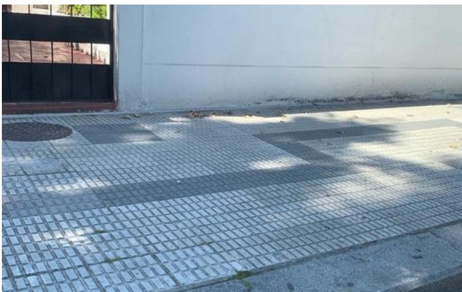
Figura 11 – Pavimento cerâmico na rua 25 de Abril em Braga
