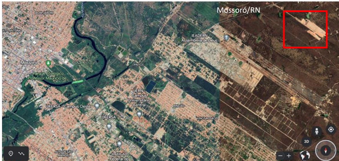
Figura 19 Localização do Aterro Sanitário Municipal de Mossoró
