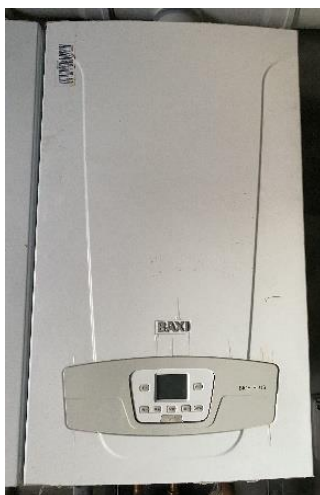
Figura 21 – Representação da caldeira a gás natural do sistema AQS.
