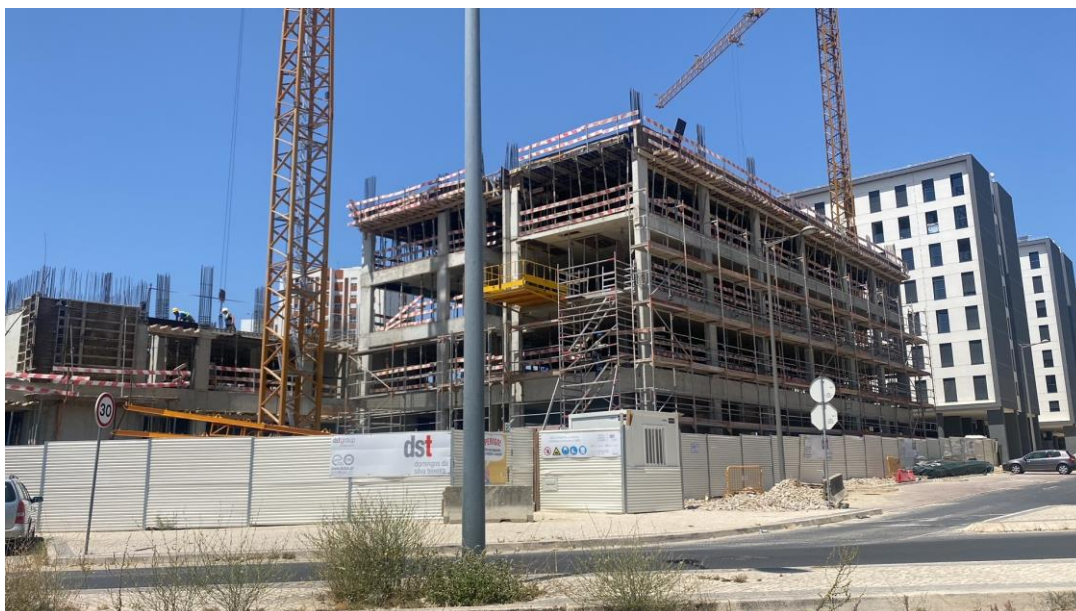
Figura 27 - Imagem real da obra em construção
