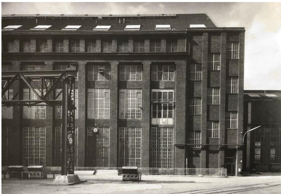
Imagem 32: Fachada oeste da Fábrica de Turbinas AEG . Mies em 1960 afirmou ter trabalhado no desenho deste alçado.
