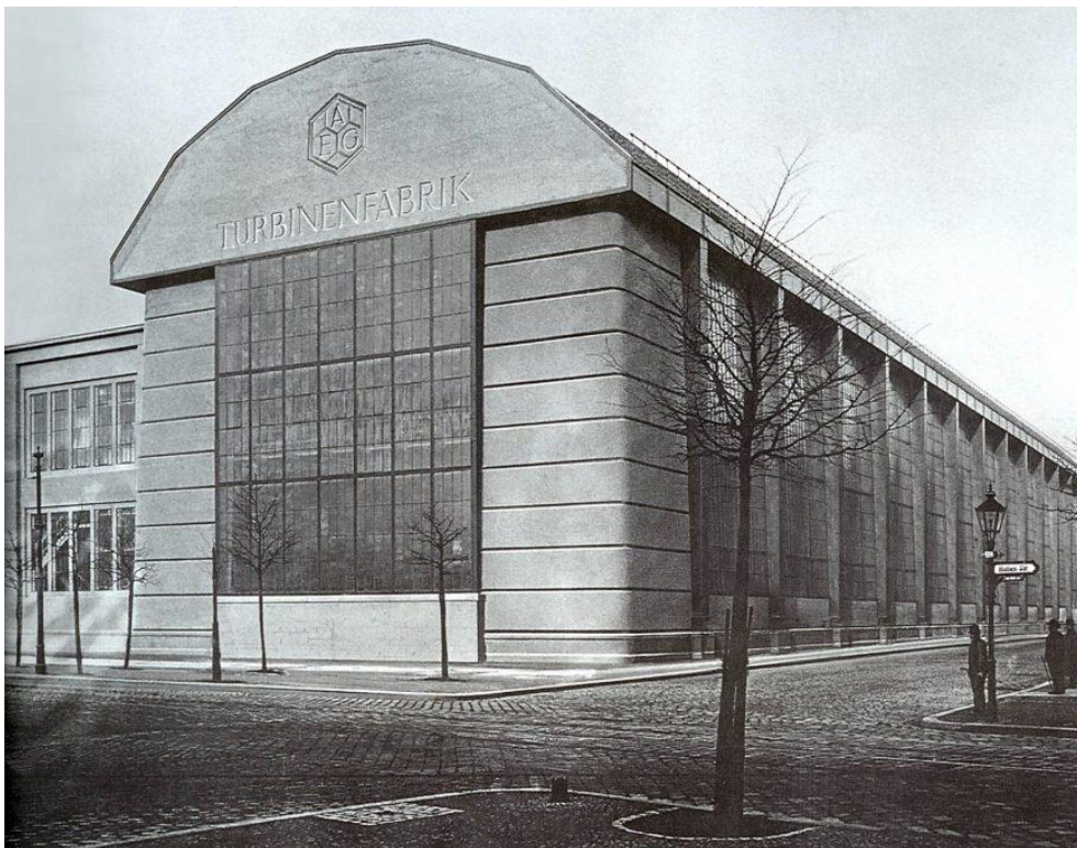
Imagem 31: Fábrica de Turbinas AEG (1907-1910), Peter Behrens, Berlim.
