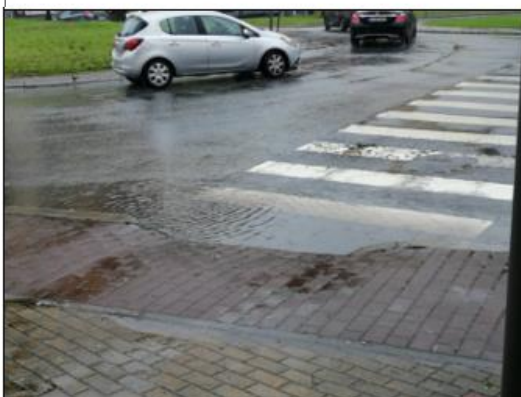
EPVNR74. “Sempre que chove, o acesso à passadeira fica neste estado. A água acumula e não tem por onde escoar. Para atravessar temo de sair da passadeira, além dos carros ao passarem molharem os peões”
