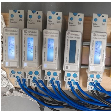
Figura 4.3 - Medidores de consumo energético dos principais componentes elétricos da ilha Futuro Expo.
