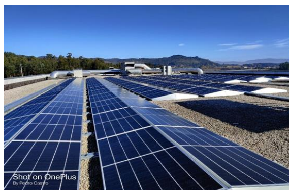
Figura 58 - a) Estrutura Nascente- Poente e inclinação com horizontal de 13° utilizada no projeto b) Vista aérea do edifício com o sistema fotovoltaico instalado.
