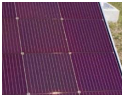
Figura 20 - Exemplo de um painel fotovoltaico de silício amorfo(Reis, 2019) .
