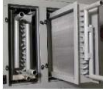
Figura 9 - Permutador de calor numa UTA
