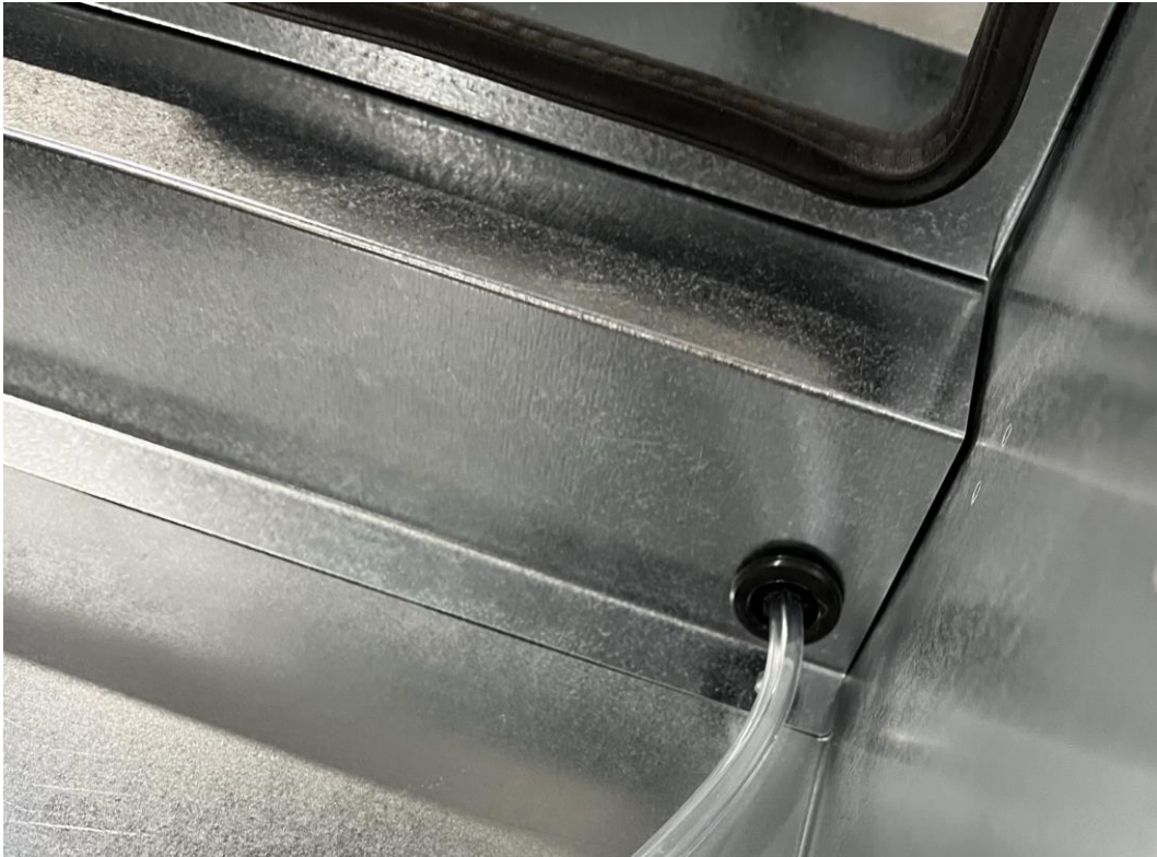
Figura 64 - Exemplos das fitas isoladoras e protetores de tubagens utilizadas
