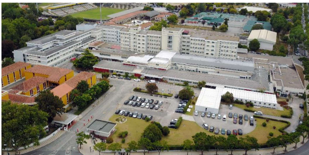
Figura 81 - Centro hospital do Baixo Vouga
