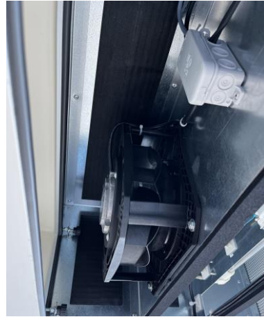
Figura 61 - Lã-de-rocha com revestimento aplicada no equipamento
