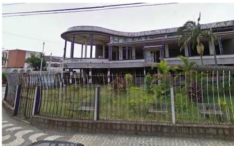
Figura 29 – Abandono do antigo Clube de Regatas Santista antes de sua demolição - Final dos anos 2000.
