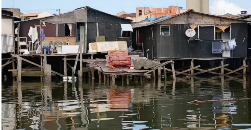
Figura 32 - Vista externa das palafitas da Vila Gilda.
