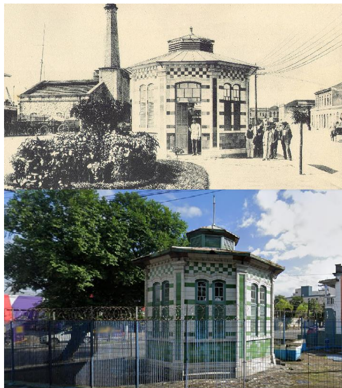
Figura 14 - Estação Elevatória - Período de inauguração e atual, respectivamente.
