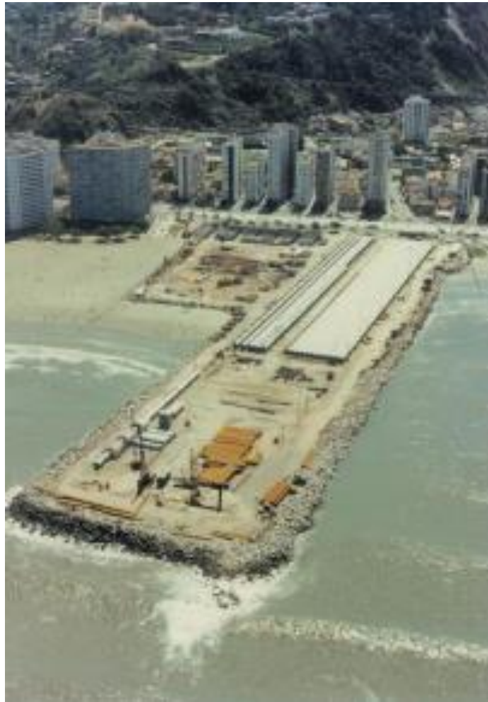
Figura 24 - Construção do Emissário Submarino - Anos 1970.
