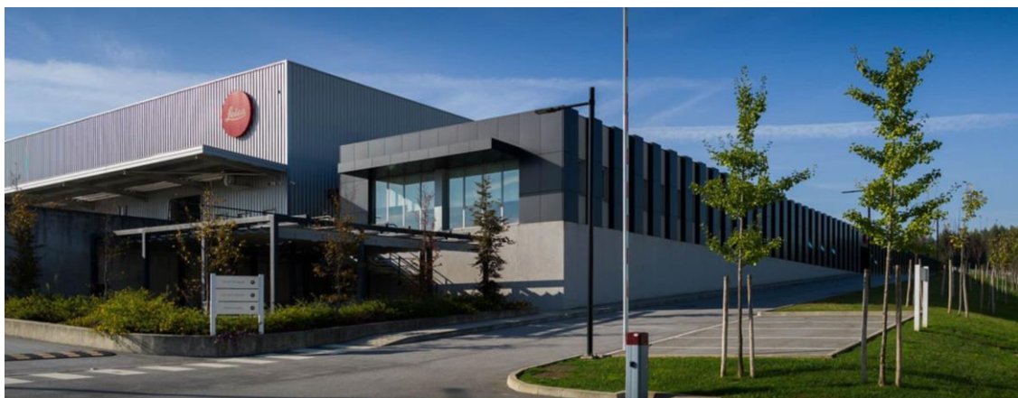
Figura 1 - Instalações Leica - Aparelhos óticos de precisão, S.A. Famalicão [1]
