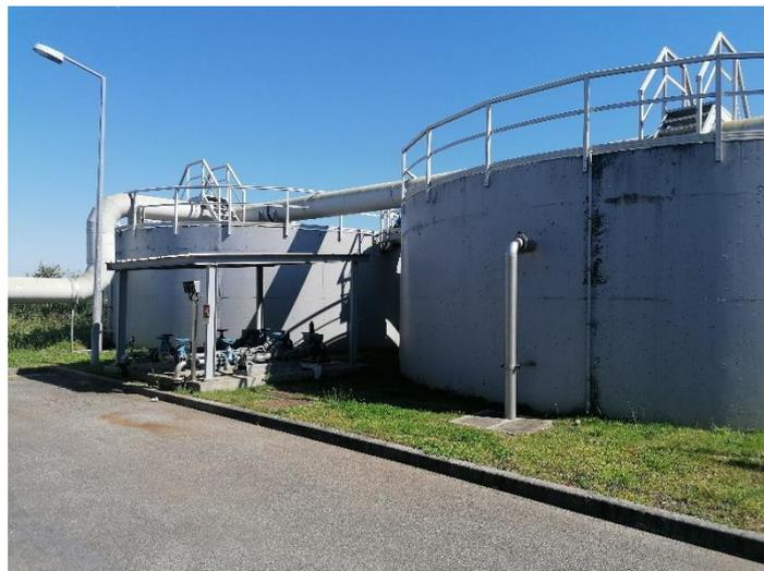
**Figura 12** - Espessadores de lama gravíticos da ETAR.
