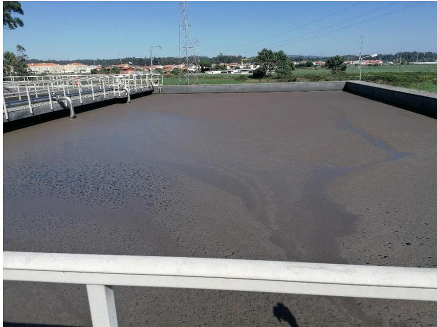
*Figura 10 - Reator biológico do tipo SBR presente na ETAR.*
