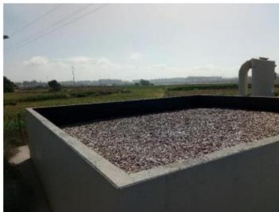
**Figura 15-** Biofiltro de estilha de pinho, associado à torre de desodorização da ETAR, retirado de (Coelho, 2018).
