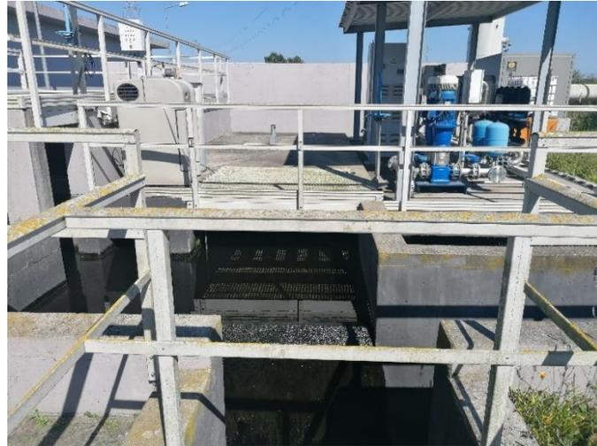
**Figura 11** - Unidade de microtamisação e desinfecção UV da ETAR.
