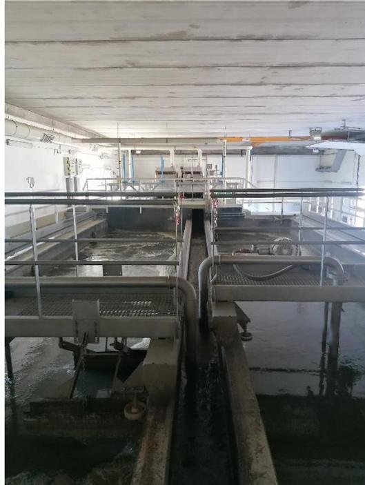
*Figura 9 - Órgãos de desarenamento e desengorduramento da ETAR.*
