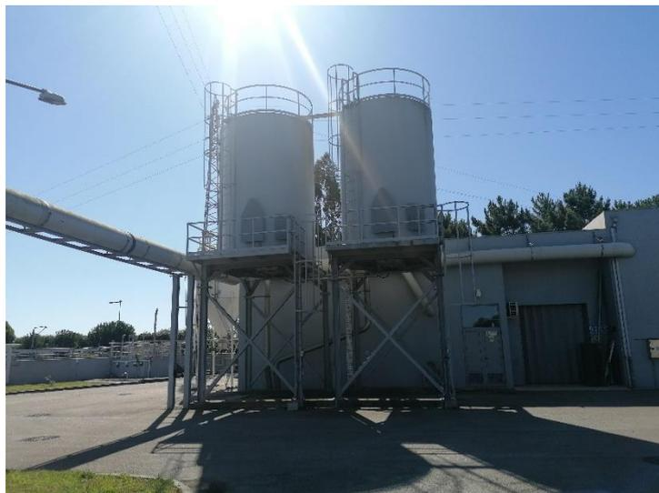
**Figura 14** - Silos de armazenamento de lamas da ETAR.
