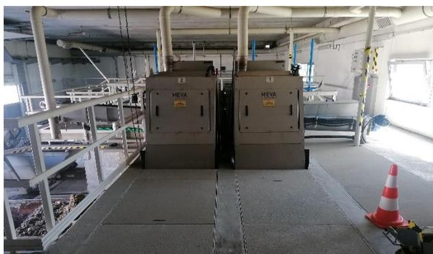
*Figura 8 - Stepscreens inseridos na etapa de gradagem da ETAR.*
