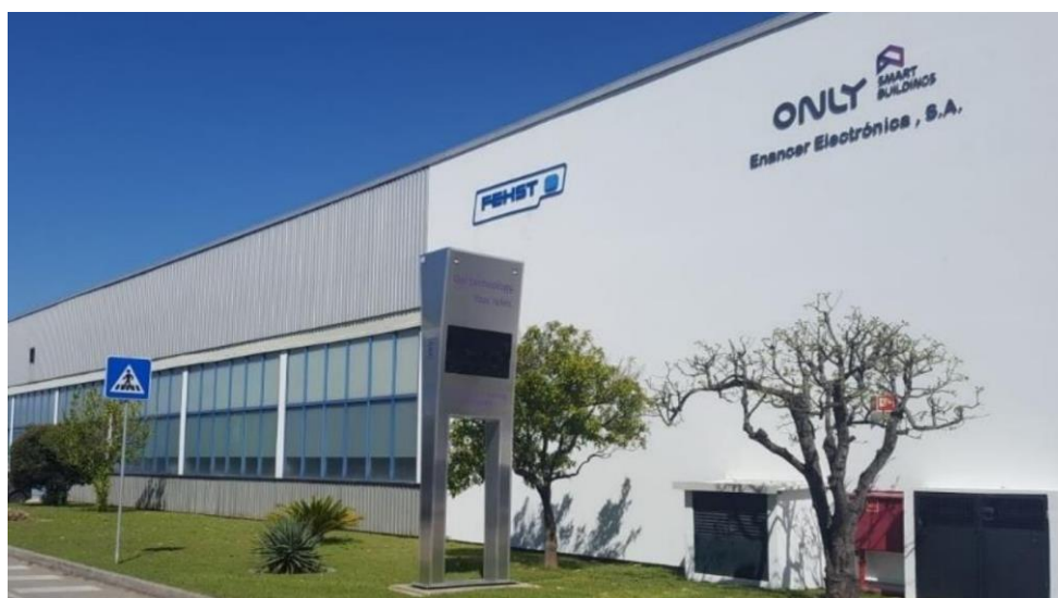
Figura 1. Instalação da empresa Fehst Componentes, Lda [1]
