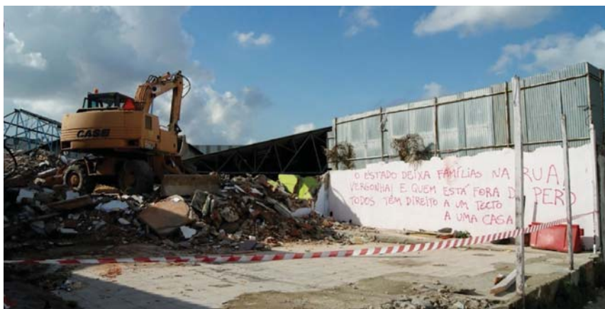
Figura 2. O processo de demolição no Bairro 6 de Maio
