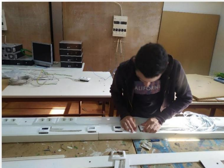
*Figura 17 - Aluno a colocar tomada de rede na calha técnica*
