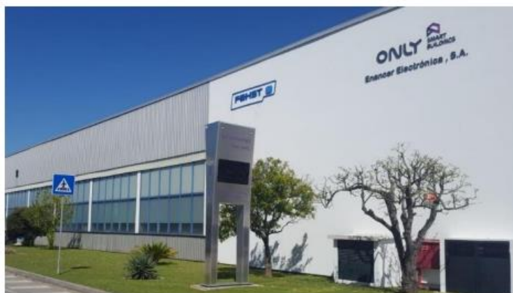
Figura 2. Instalações da Empresa Fehst Componentes, Lda [1]
