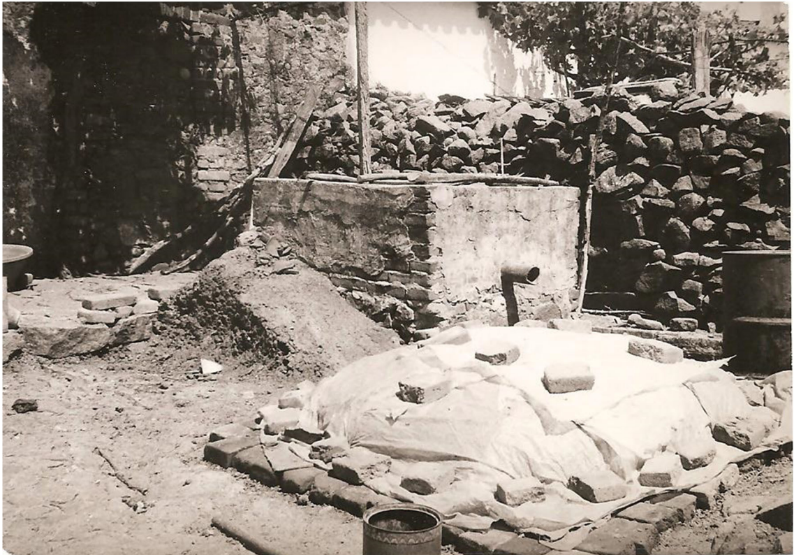
Barro guardado no aloque, Barcelos. Fonte: Arquivo fotográfico nº102 do Museu da Olaria de Barcelos
