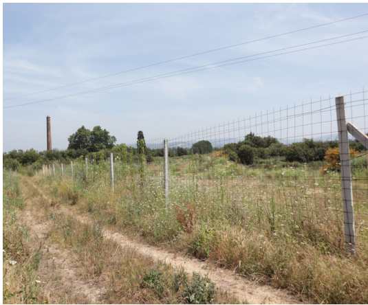
Figura 39: Colocação de Vedações.
