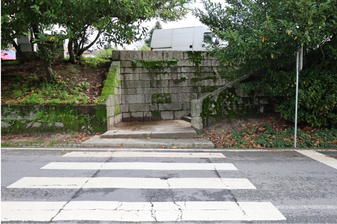
Figura 22 - Passadeira e escadaria no acesso aos caminhos do castelo
