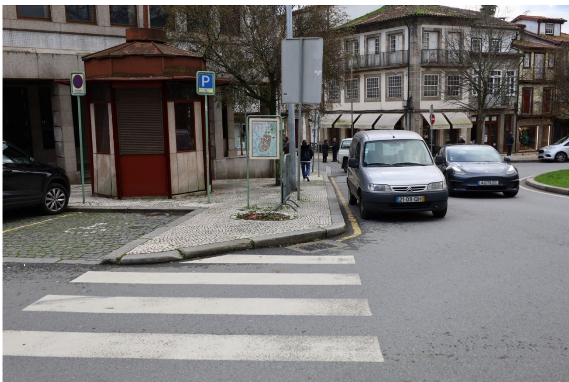
Figura 36 - Passeio com falta evidente de rampa na Rua Val de Donas
