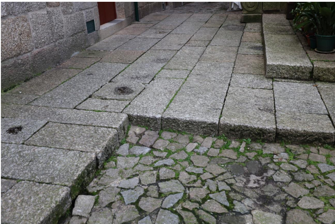
Figura 40 - Passeio alto e sem rampa na Praça de S. Tiago
