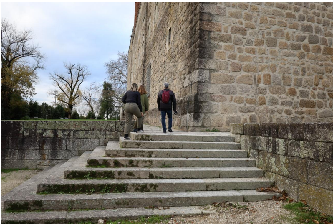
Figura 19 - Escadaria adjacente ao Paço dos Duques de Bragança
