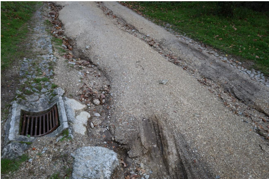
Figura 23 - Piso completamente desfalcado nos caminhos do castelo
