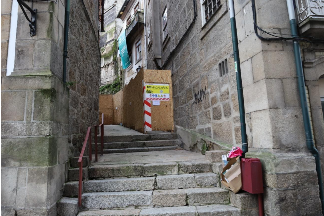
Figura 44 - Escadaria adjacente à rua D. Maria II
