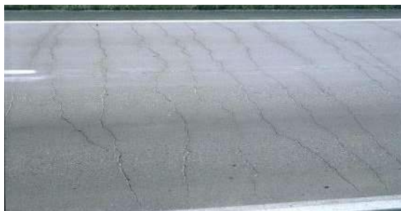
Figura 2-3 – Fendilhamento térmico em um pavimento (Behnia et al., 2018)
