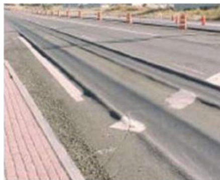
Figura 2-5 – Deformação permanente na mistura betuminosa (Marlene & Maia, 2012)
