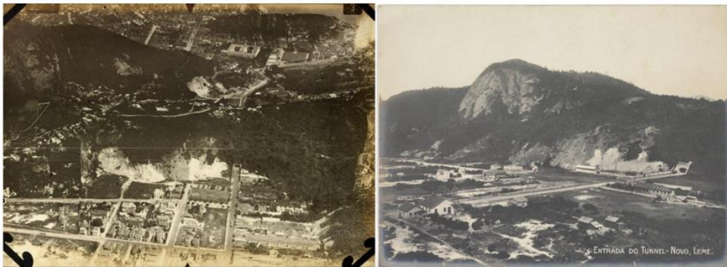
Figura 23. Imagens do Túnel Novo, Túnel do Leme ou Coelho Cintra. Coelho foi o engenheiro responsável pelas obras do Túnel Alaôr Prata. A primeira imagem mostra o túnel em cartografia aérea, mostrando na porção inferior da imagem, Copacabana, e na superior o bairro de Botafogo, separados pelo morro de São João, circa 1921. Autor: Jorge Kfoury. A segunda imagem mostra em panorama a entrada do túnel a partir do Leme, em 1907. Sem autoria. Fonte: Brasileira Fotográfica https://brasilianafotografica.bn.gov.br/ . Acesso em agosto de 2022.
