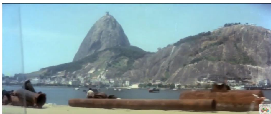
Figura 96. Tubulões das obras de duplicação Copacabana.
