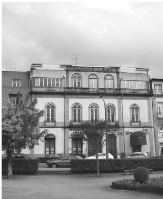
Fig. 2: O mesmo edifício, ocupado por um restaurante e diversos apartamentos (2008)
