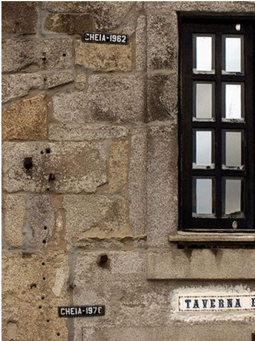
Figura 4—Demarcação de cheias na fachada de uma habitação no Porto.
