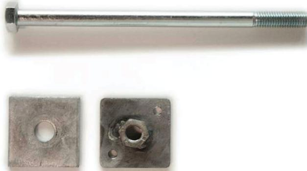
**Figura 3.13.** Elementos de ligação nos painéis de madeira.
