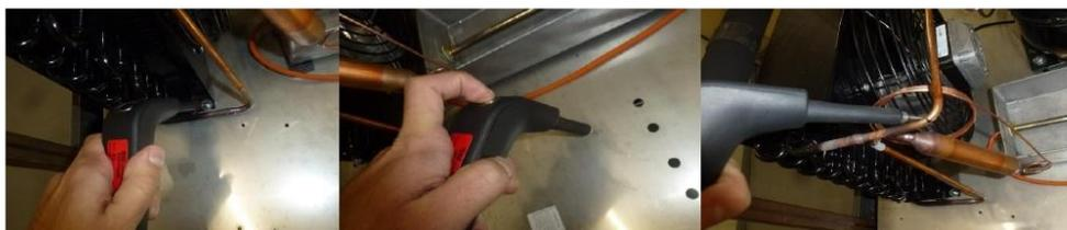
Figura 7- Verificação da continuidade terra em 3 pontos distintos da unidade condensadora.
