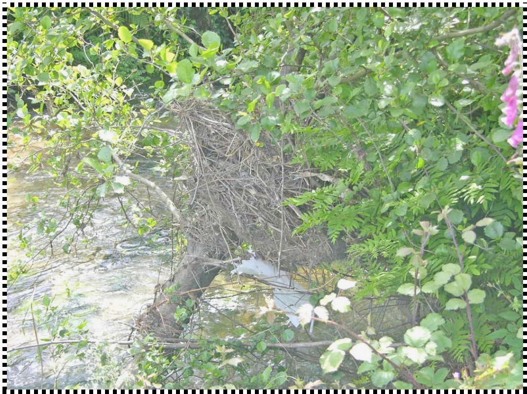
Fig. 4.13. Rio Neiva em Cossourado. Canal com leito e margens de aluvião. A vegetação é abundante, invade o canal e nela ficam retidos os destroços e lixo (visível na foto inferior, pormenor do campo assinalado na primeira).
