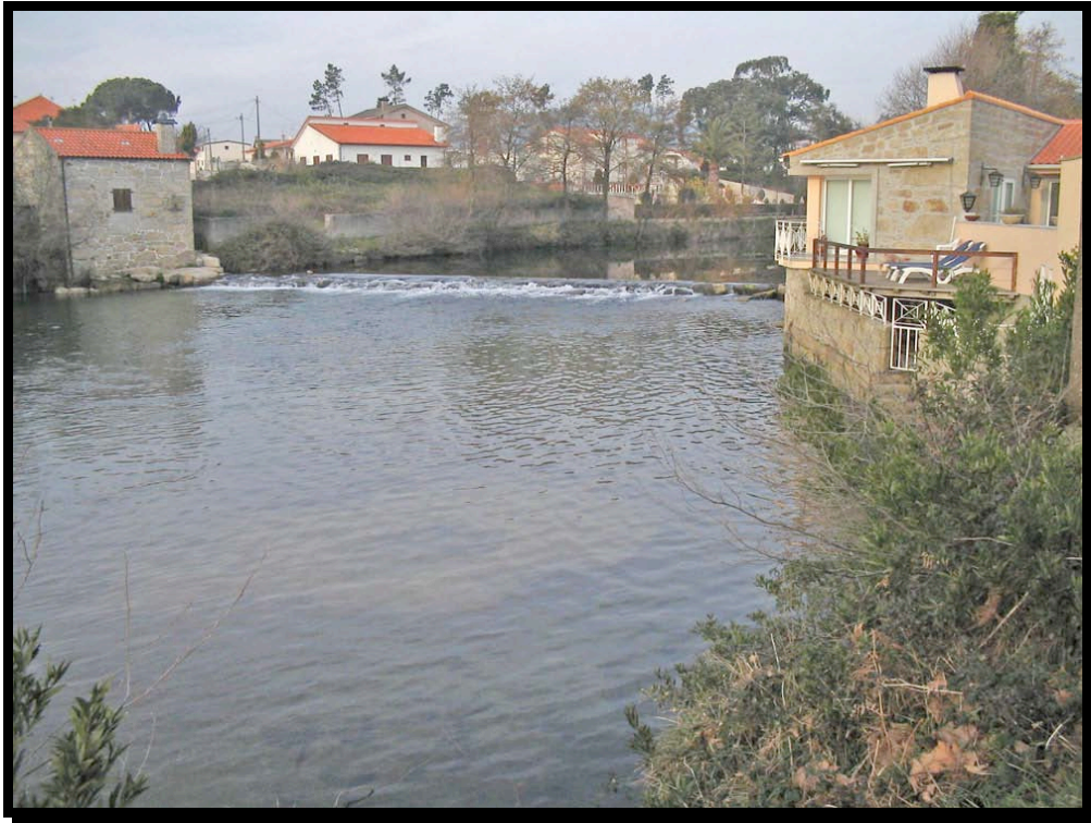
Fig. 4.17. Construções nas margens do rio, no tramo final, em Santa Tecla.
