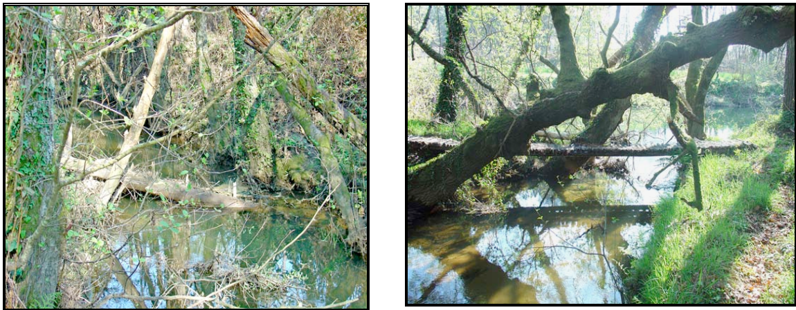
Fig. 4.23. Falta de limpeza no canal e vegetação arbórea invadindo o canal.
