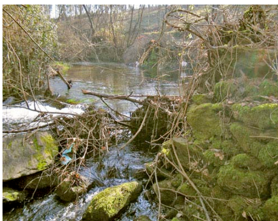
d) Wood debris retidos pelos blocos no leito e nas margens do canal. Arcozelo.
