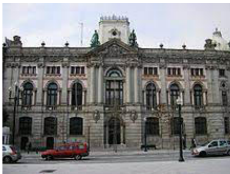
Figura 1: Instalações do Banco de Portugal, Porto
