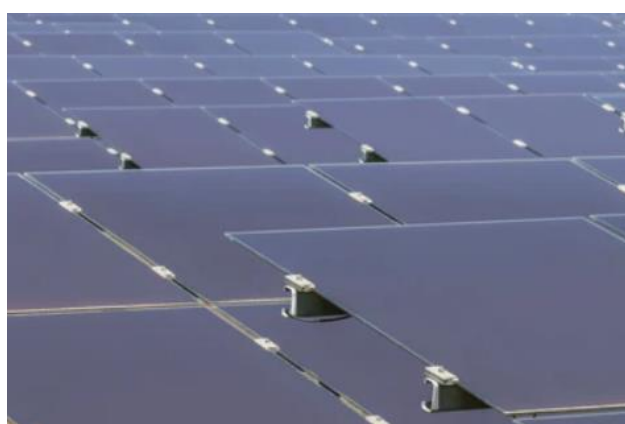
Figura 2.3 - Célula solar fotovoltaica de silício amorfo [43].
