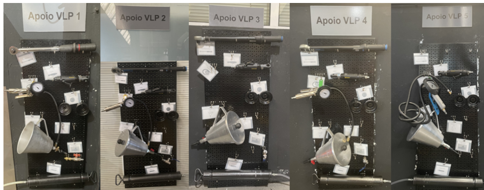
Figura 55: Implementação dos quadros e identificação das zonas
