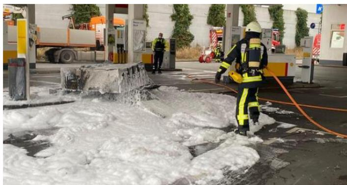
Figura 2.1 - Espuma líquida utilizada em incêndio de combustíveis [3]
