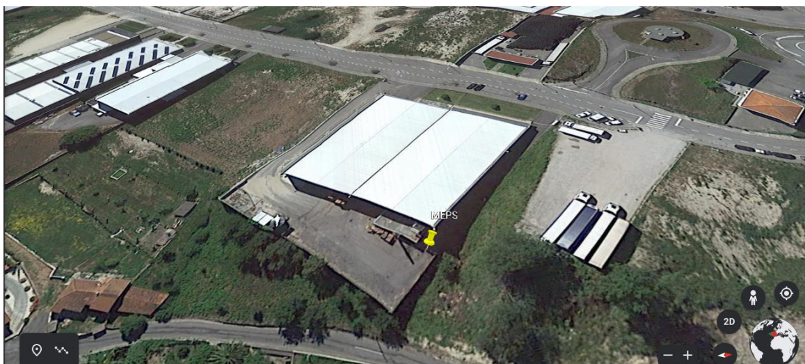
Figura 17 - Indústria onde se procede a instalação do sistema fotovoltaico (Fonte: Google Earth).
