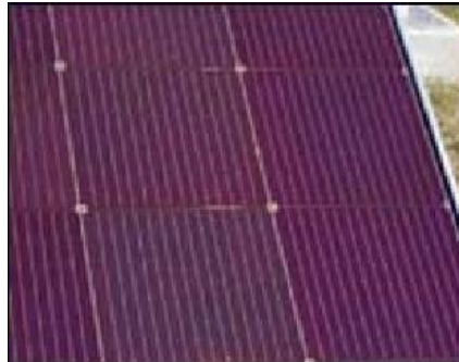
Figura 13 - Células solares de silício amorfo (Alves Freitas, 2008).
