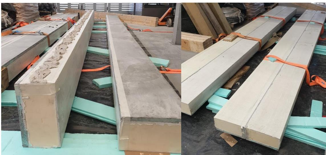
**Figura 38.** Processo de colagem dos painéis duplos.
