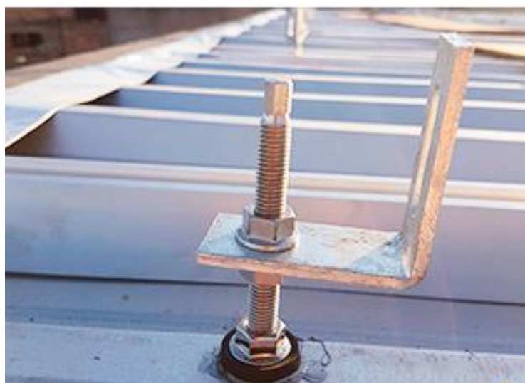
Figura 8.13 - Parafuso de fixação de estruturas em telhados de telha metálica [70]
