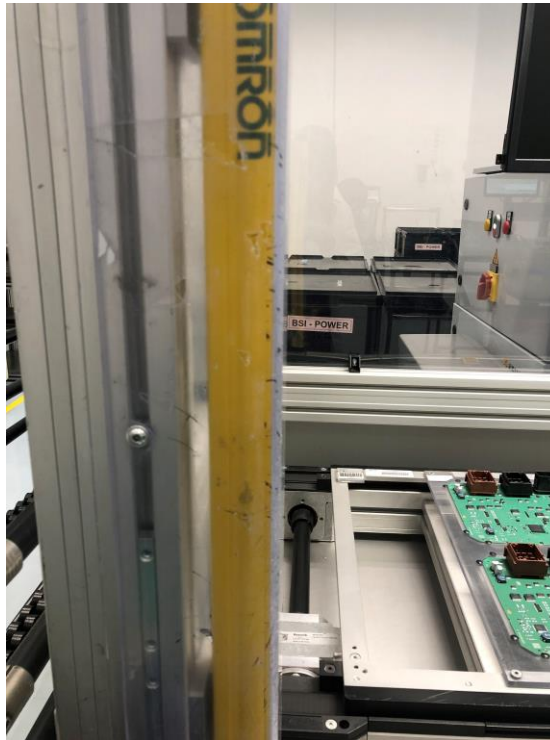
Figura 43: Evidência de choque das placas na barra de segurança.
