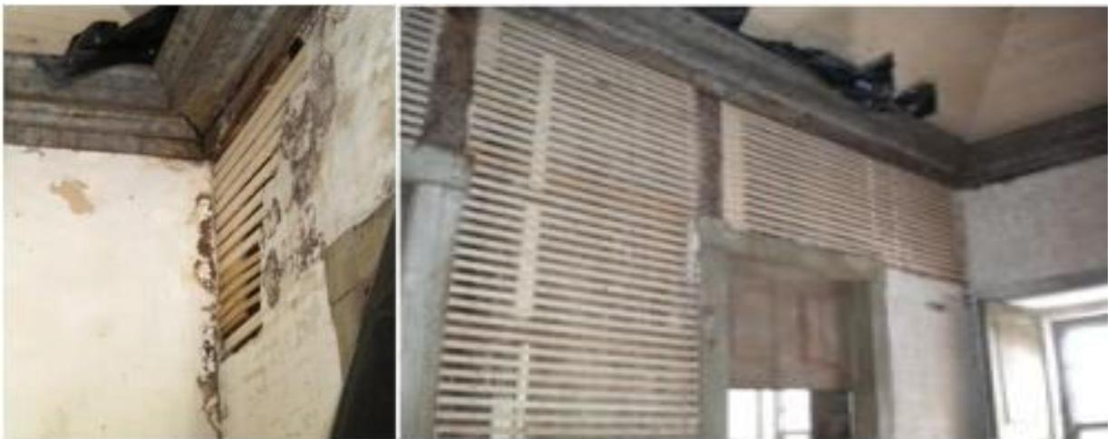
Figura 3: Estado de degradação e reparação das paredes de tabique [4]
