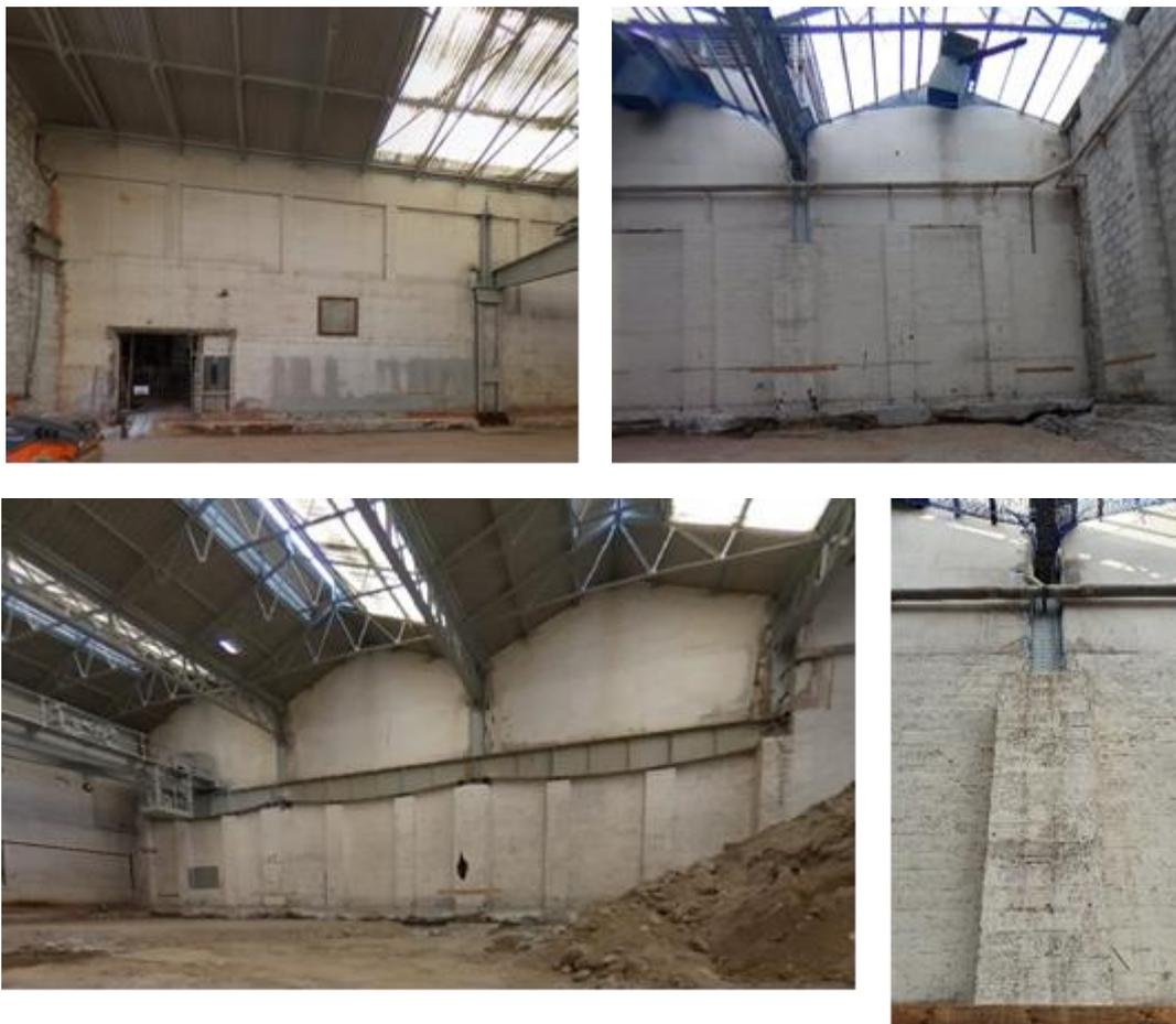
Figura 4: Paredes não estruturais e colunas metálicas
