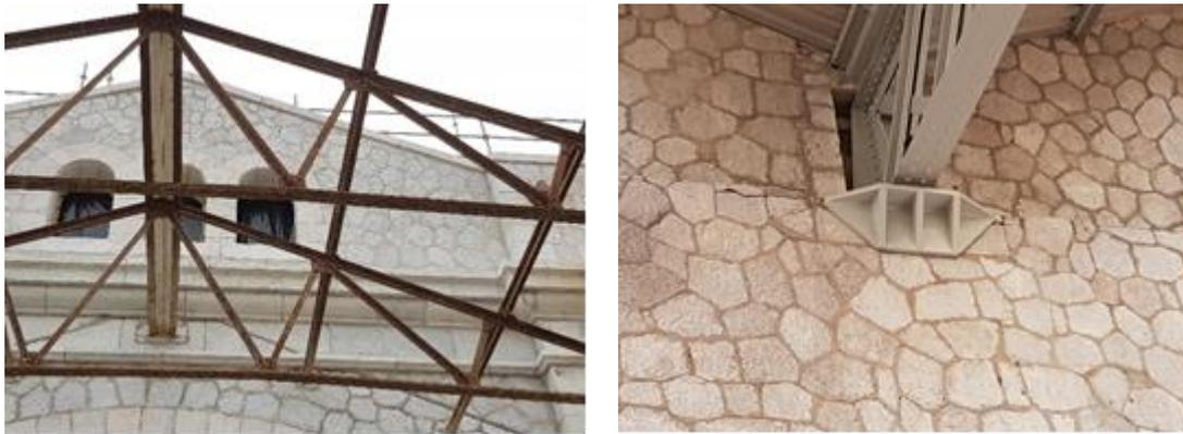
Figura 3: Edifício B, exemplo de ligações entre vigas metálicas e paredes portantes em alvenaria de pedra
