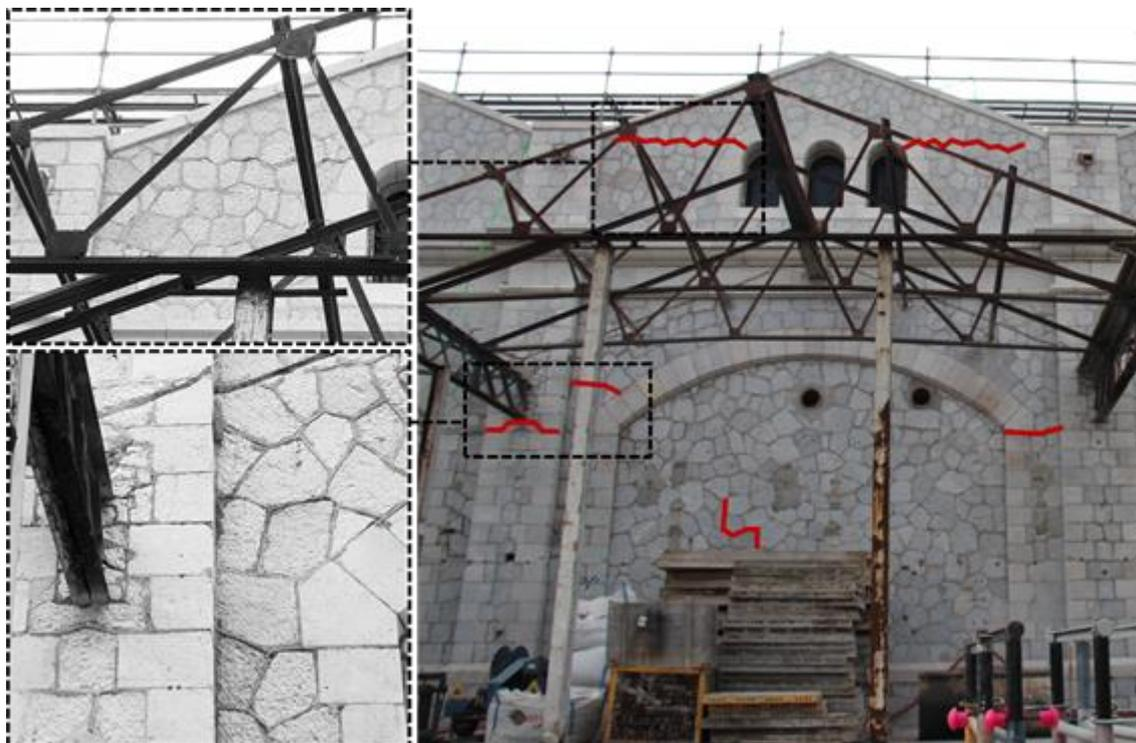
Figura 7: Padrão de fissuração na fachada leste
