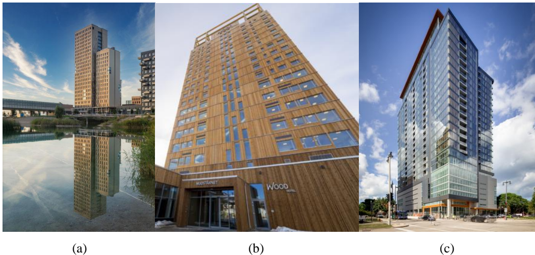
Figura 1: Edifícios em altura que recorreram à madeira como principal material estrutural. a) Empreendimento residencial-comercial HoHo [22]; b) Torre Mjøstårnet [23]; c) Torre Ascent [24].
