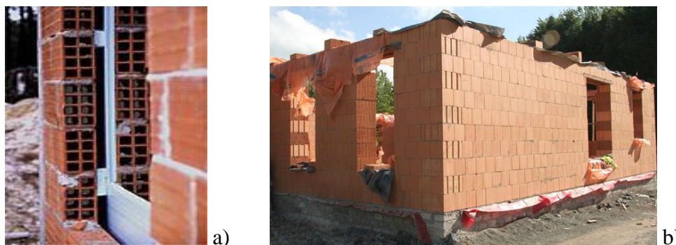
Figura 5: Soluções de paredes de a) preenchimento e de b) alvenaria estrutural. Para quê paredes de preenchimento quando podemos ter paredes resistentes?
