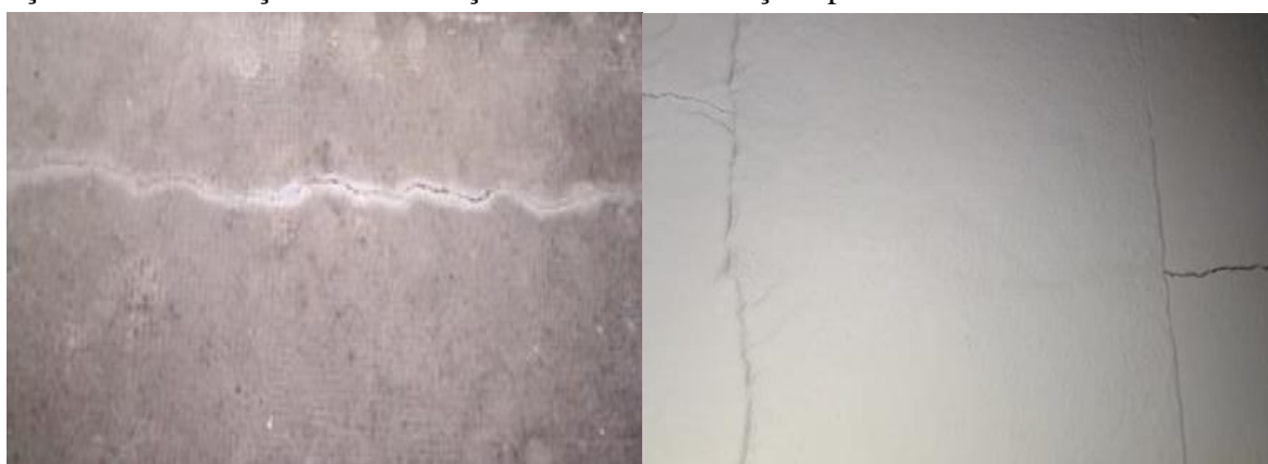
Figura 2: Demonstração das consequências de desempenho insuficiente (resultando em fissuração do conjunto) e satisfatório, entre membranas de impermeabilização e estruturas de reforço após 2 anos de serviço (esquerda: rede de fibra de vidro combinada com membrana acrílica; direita: não tecido com membrana em poliuretano de base solvente).
