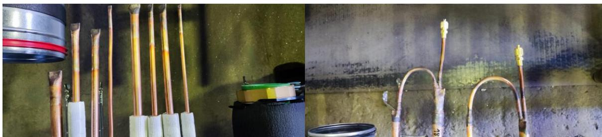
Figura 52 - Tubagem de cobre isolado pressurizado com Azoto, a 41 bar, para que o soldador responsável pelas uniões em obra se aperceba da ocorrência de fugas, no sistema de climatização.
