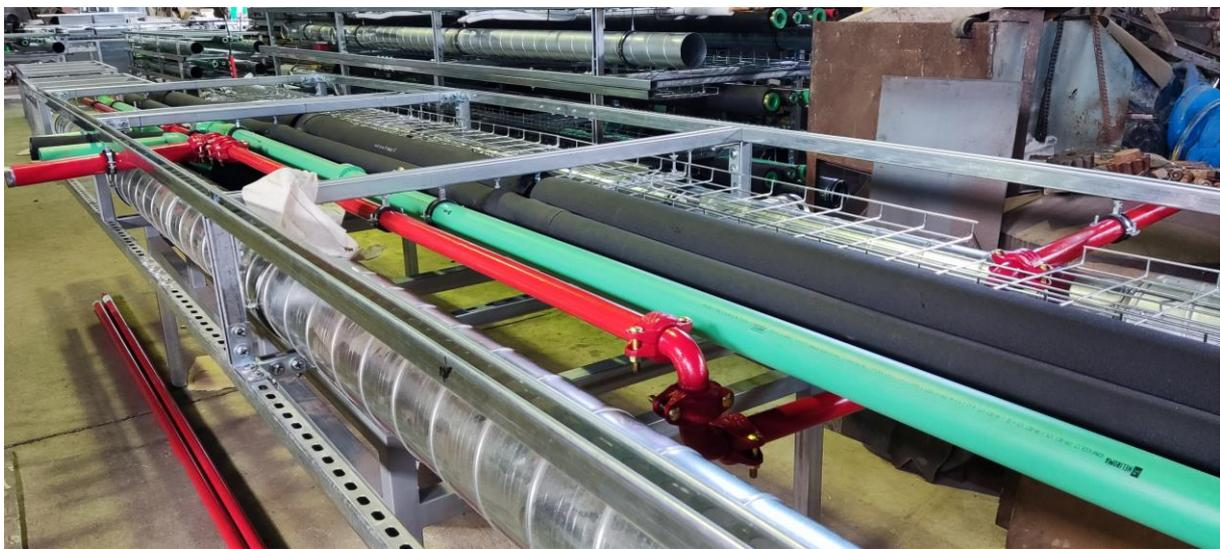
Figura 54 – Picagem da rede de abastecimento de água contra incêndio sobre as tubagens PPR responsáveis pelo abastecimento de água, no rack D.
