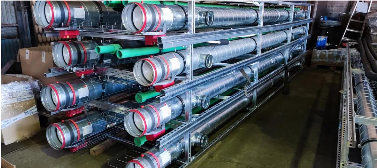
Figura 51 – Rack A dos corredores dos Pisos Tipo do hotel, verificando-se que os registos corta fogo se encontram na extremidade dos módulos.
