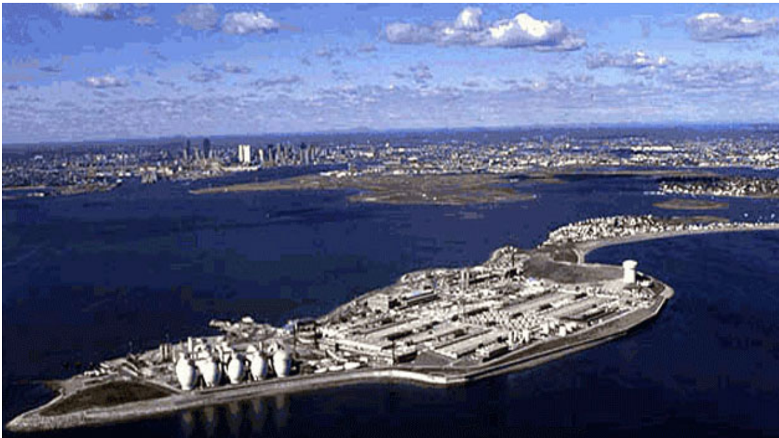
Fotografia 1 – Vista aérea da ETAR de Deer Island para tratamento do efluente gerado por 3.000.000 de pessoas
