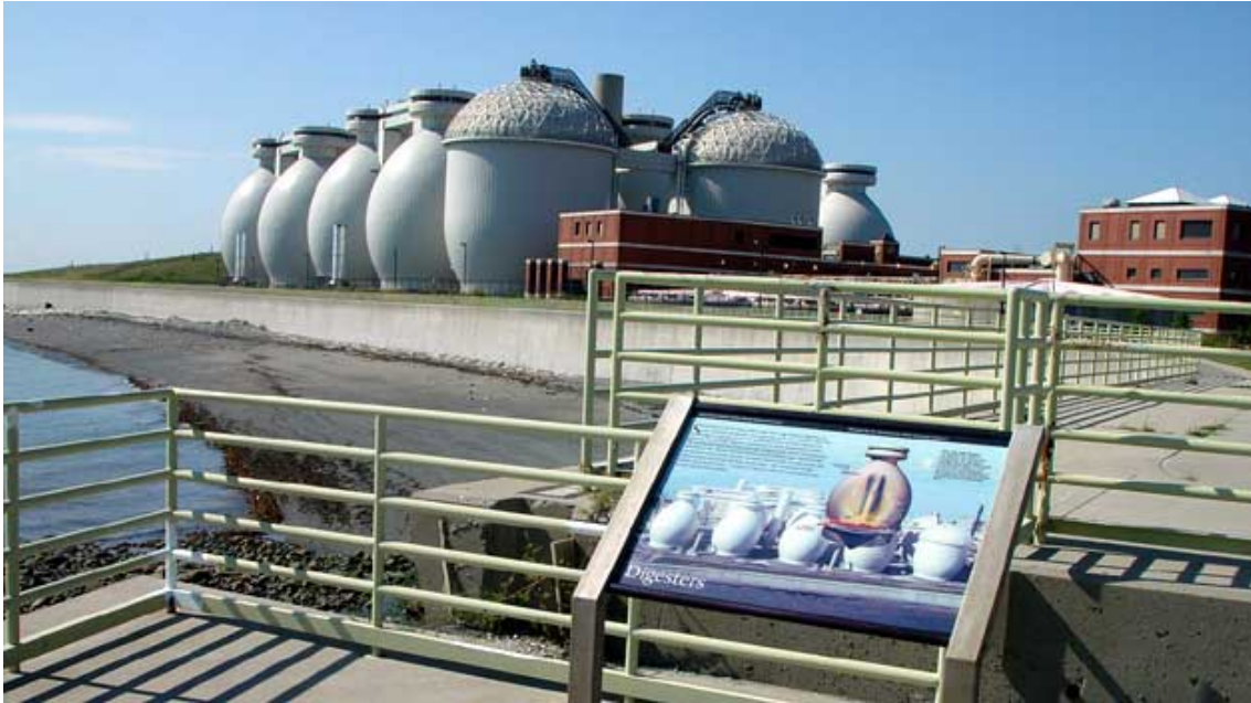
Fotografia 2 – Vista dos digestores da ETAR de Deer Island
