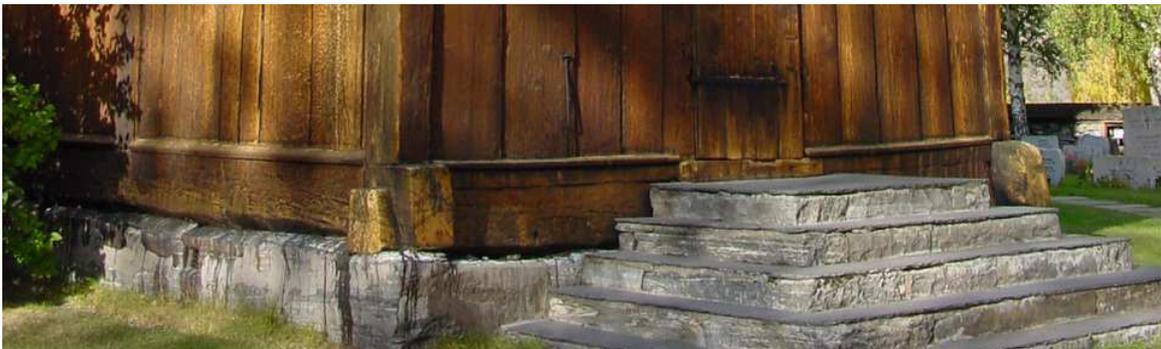
Figura 6-Base em pedra por forma a evitar o apodrecimento por humidade ascensional.
