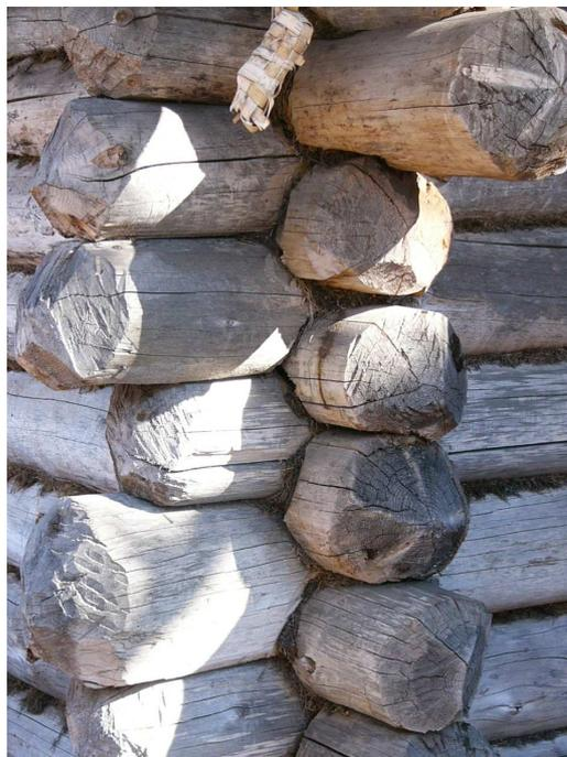
Figura 1-Técnica construtiva em "laft"
