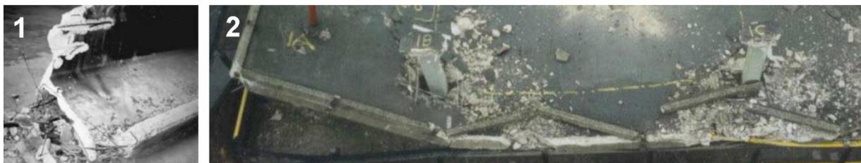
Figura 1.5 - Colapso de viga pré-esforçada em Verona (1) e de uma laje em Wolverhampton (2)
