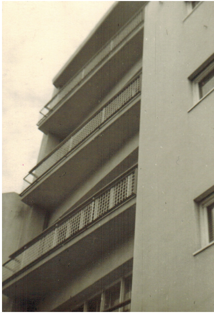
F.29. Varandas da Fachada Norte
