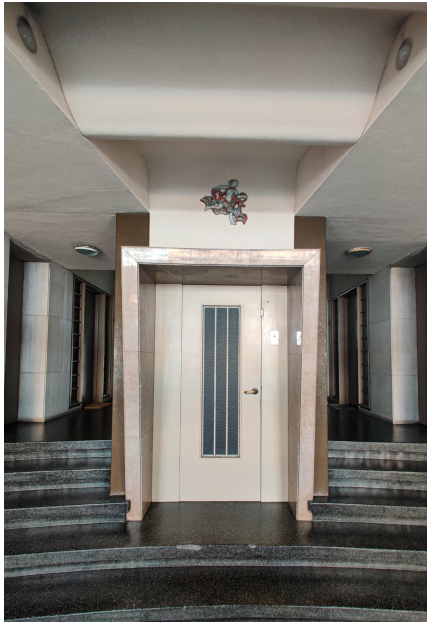
F.36. Teto Átrio Entrada Vista Sul
