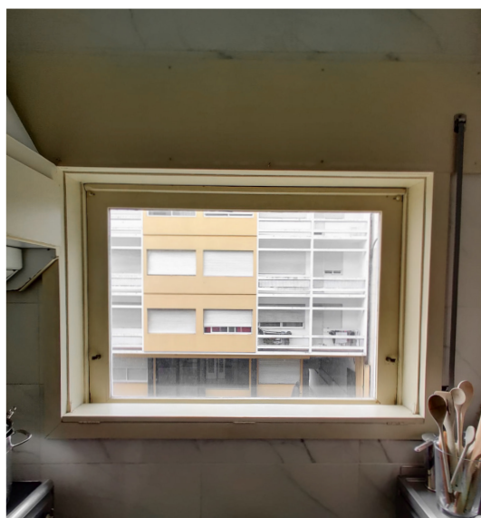
F.41. Fotografia Fachada Interior Janela Cozinha
