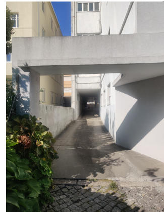
F.03. Passagem Acesso Garagens
