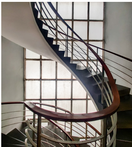
F.12. Escada Piso R/C
