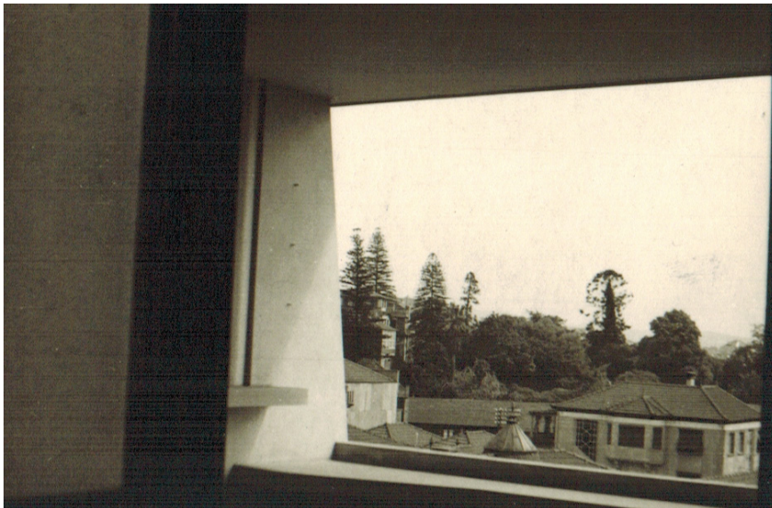
F.31. Vista Interior do Terraço voltado a Sul
