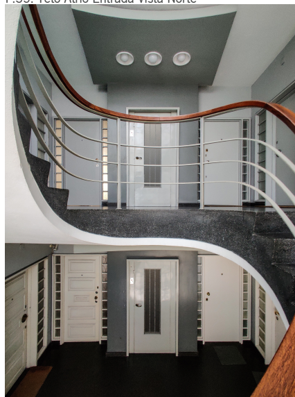
F.37. Teto Hall de Acesso aos Apartamentos
