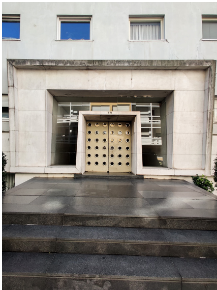
F.05. Passadiço Entrada
