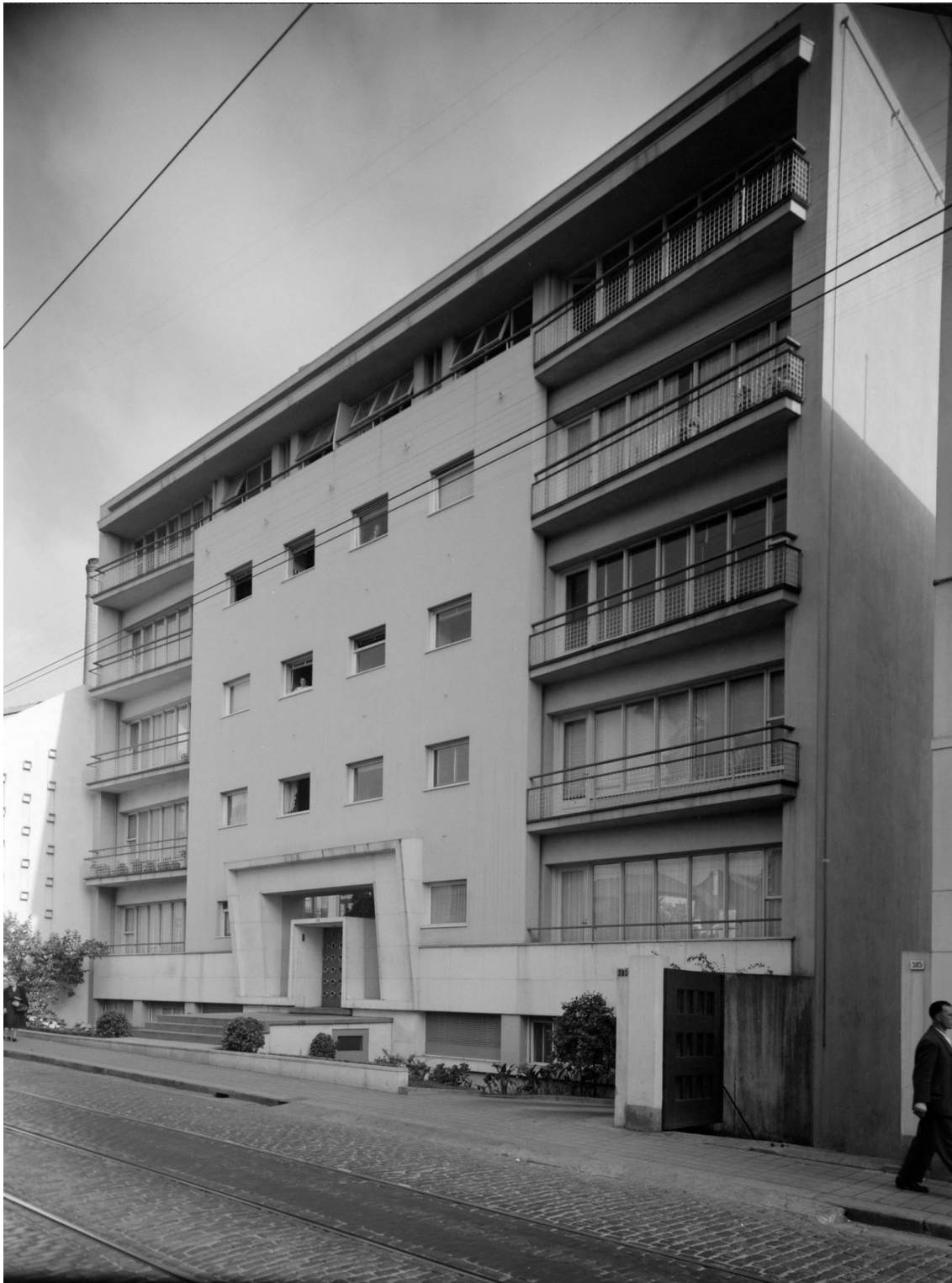
F.01. Fotografia Original da Fachada do Bloco da Carvalhosa
