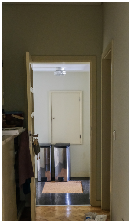
F.39. Rebaixamento do Teto do Vestíbulo da Entrada de Serviços do Apartamento
