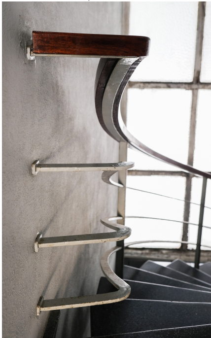
F.10. Pormenor do Corrimão Escada
