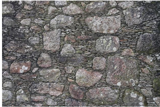
Figura 53. Casa na aldeia da Montaria, com paredes construídas com blocos de granito e pequenos pedaços de xisto (pormenor na fotografia da direita).
