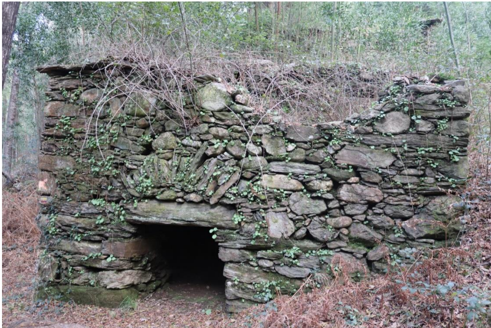
Figura 96 . Moinho localizado nas margens do rio Âncora, construído maioritariamente com rochas metassedimentares, no percurso pedestre PR4 (Trilho do Pôr do Sol).
