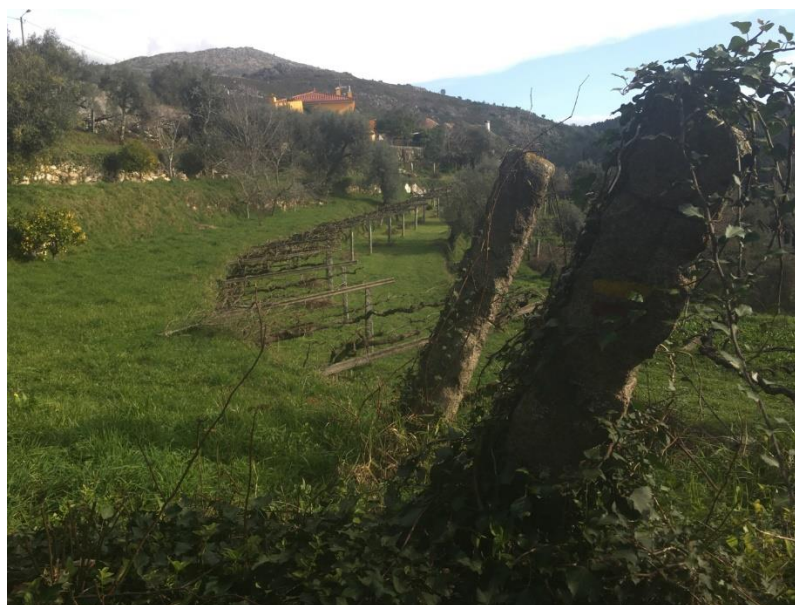
Figura 94 Esteios de ramada em granito, em campo agrícola junto à aldeia de Trás-Âncora.
