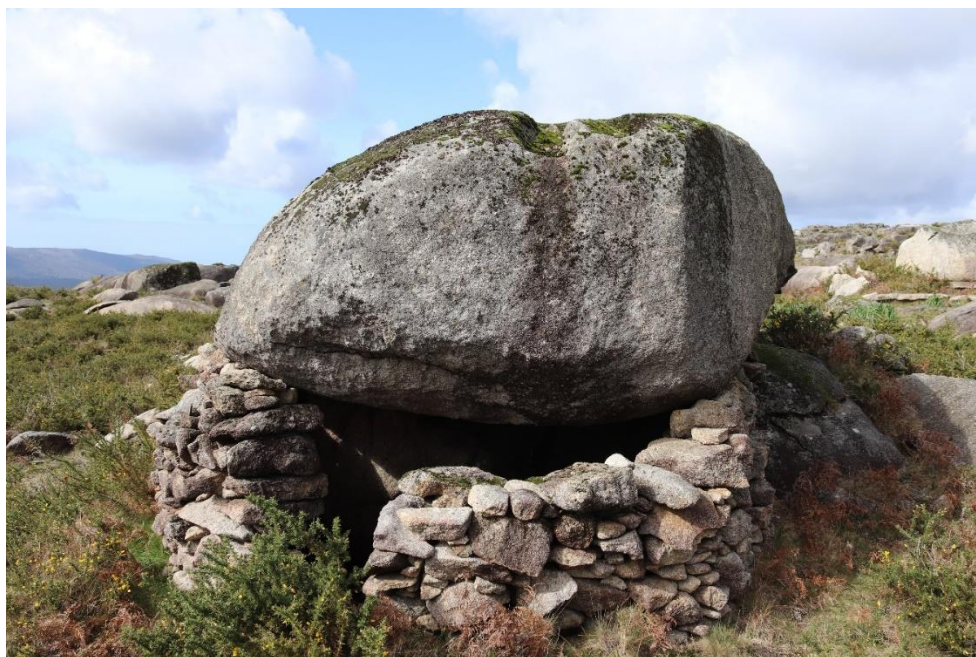
Figura 70 Estrutura cercada (cabana/curral) construída com o aproveitamento de bloco granítico em equilíbrio, no percurso pedestre PR3 (Fojo do Lobo).
