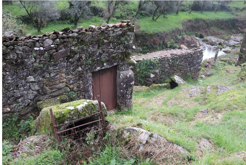
Figura 55. Moinhos da Costa, contruídos em granito e xisto (não operacionais), junto à aldeia da Montaria.
