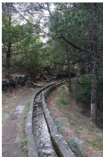
Figura 99 Conduto de transporte de água (levada) contruída em granito, no percurso pedestre PR4 (Trilho do Pôr do Sol).
