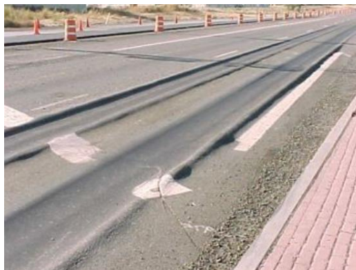
Figura 2.4 - Deformação permanente na mistura betuminosa (Franco, 2007)
