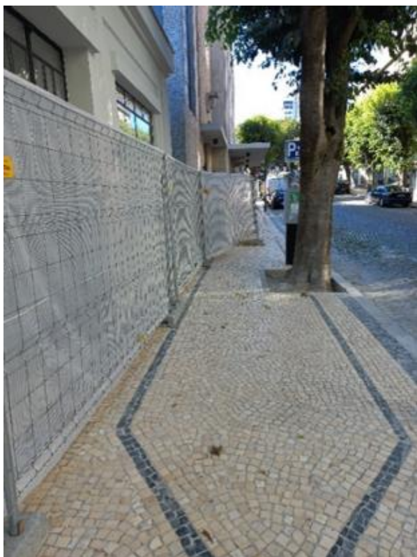
Figura 29 - Obras na Av. Dom Afonso Henriques
