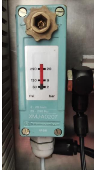
Figura 43 - Interruptor de pressão da Telemecanique , modelo XMJ-A0207
