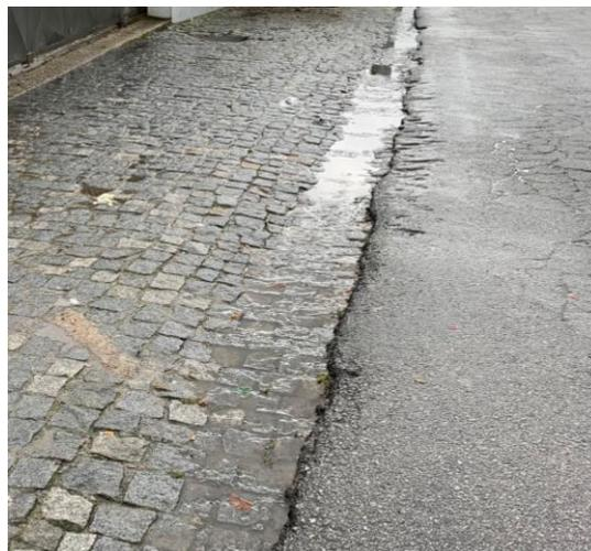
Figura 25 - Piso desnivelado junto ao cais 8
