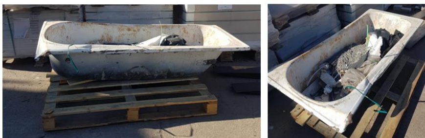
Figura 48: Banheiras destinadas à recolha de entulho
