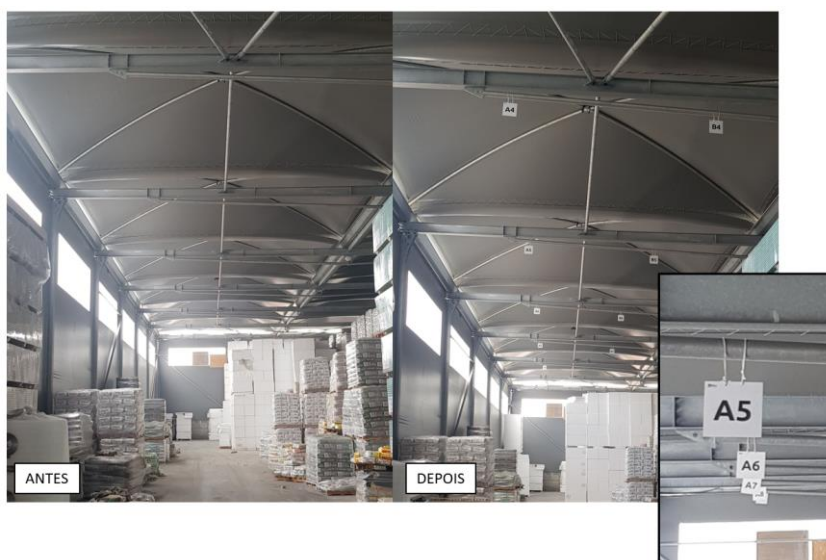
Figura 32: Mapeamento do corredor A e B da tenda, antes de depois da intervenção
