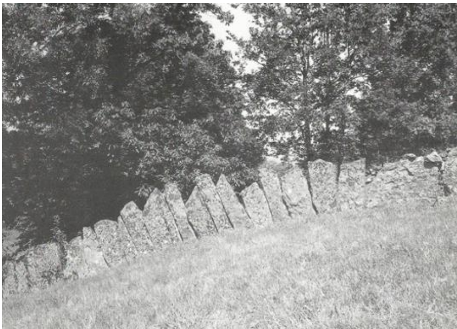
Figura 5: Muro de pedra à vista em lajes verticais
