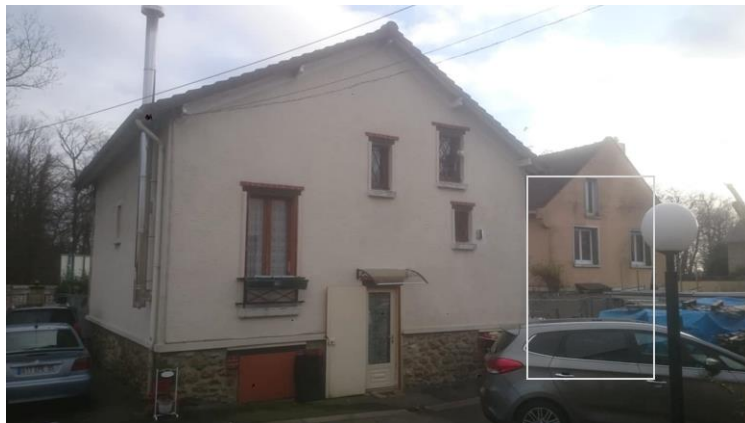
Figura 39: Fachada traseira da casa existente com identificação da área a intervir
