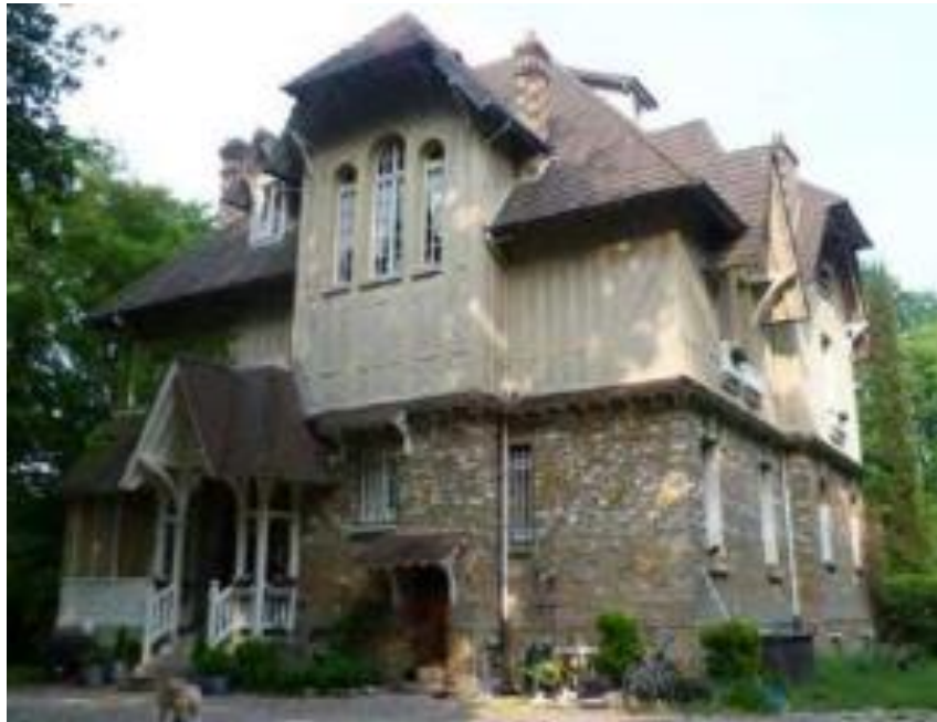
Figura 24: A complexidade dos volumes e dos telhados de grandes inclinações de formas complexas com os caleiros, Eaubonne
