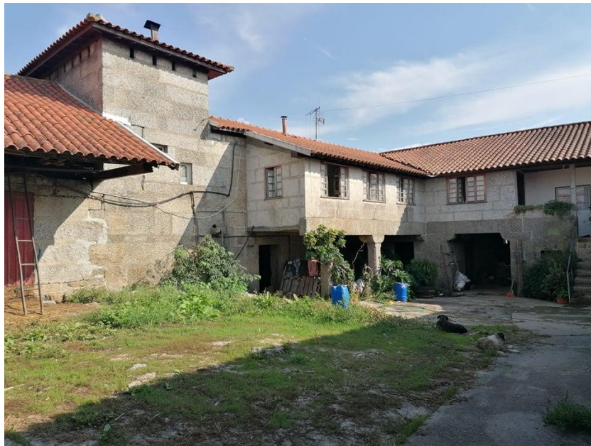
Figura 7: Fotografia da zona interior da Quinta do Paçô, casa de lavoura em Prazins Santo Tirso
