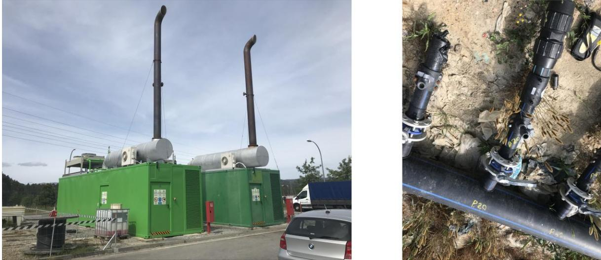
Figura 40 - CVEB composta por 2 motogeradores (à esquerda) e rede de captura de biogás (à direita)
