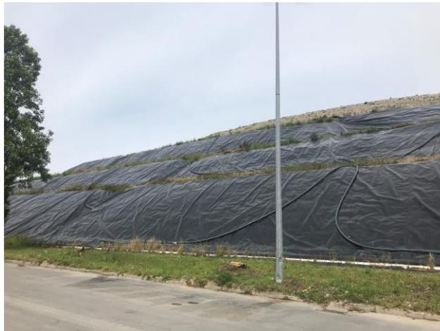
Figura 39 - Célula do aterro e condutas de condução do biogás
